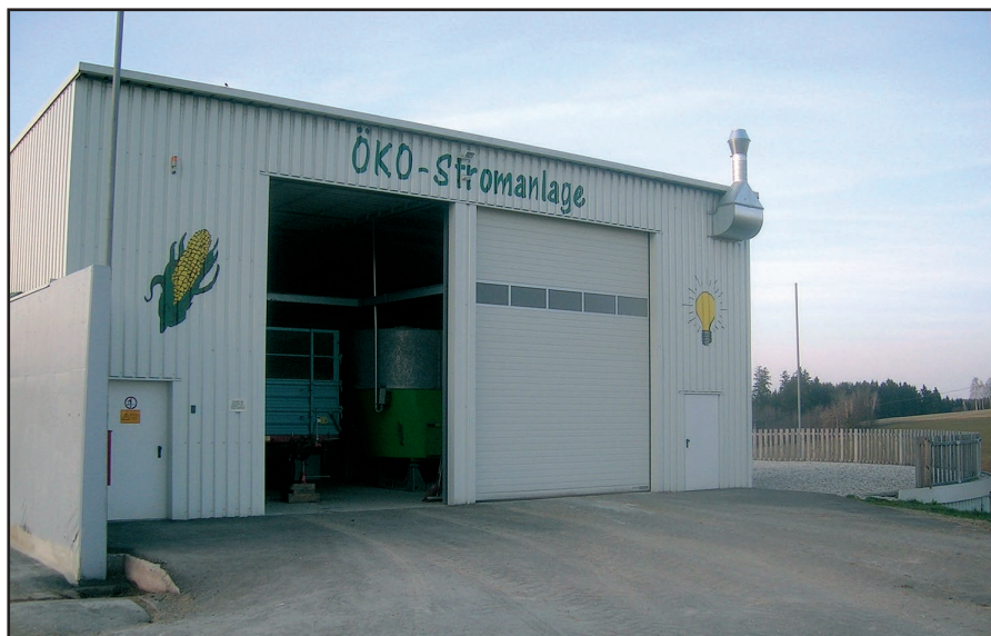
Obr. 2: Příklad zemědělské BPS, která je vhodným způsobem začleněna do blízké zástavby rodinných domů v obci Miesenbach v Horním Rakousku.
