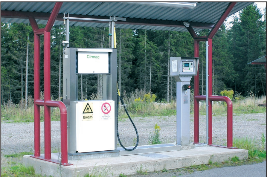
Obr. 7: Čerpací stanice na bioplyn upravený pro pohon automobilů ve švédském Boras.
